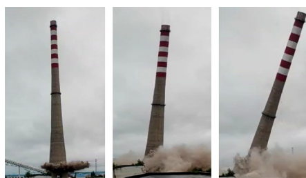
图 7 烟囱倒塌过程
