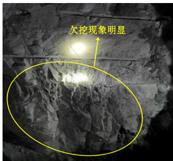
图 5 光爆试验欠挖现象
