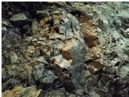
图 2 西二采区崩落法采场揭露的破碎矿岩
