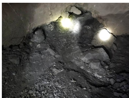
图 4 炸药单耗过大爆破后形成的大量粉矿
