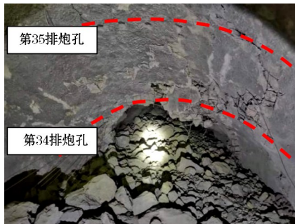
图 1 1580 m 分段 4 # 进路第 32 排炮孔爆破后的爆堆状态
